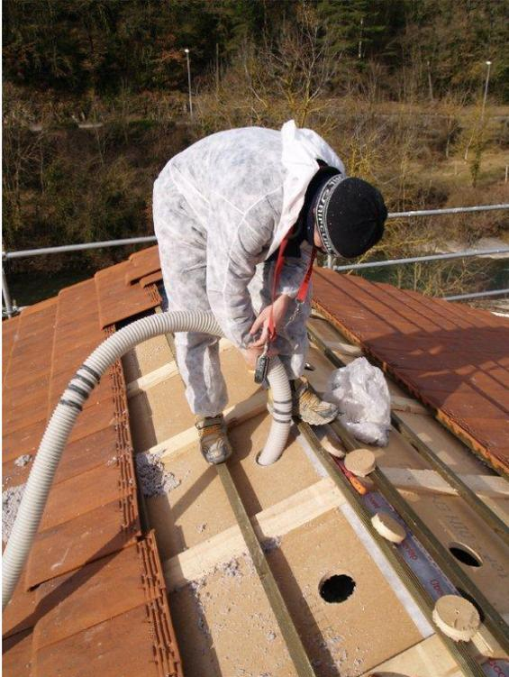
Foto: Proceso constructivo. Insuflado celulosa en cubierta – Fuente: Bau Passivhaus sl
