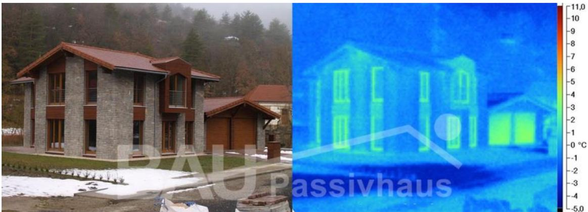
Edificación pasiva: Casa Arias en Roncal (Navarra). Temperatura media de fachada -0,5°C. Termografía realizada con temp. int. de 21°C y en el exterior -1°C. Fuente: Bau Passivhaus sl
