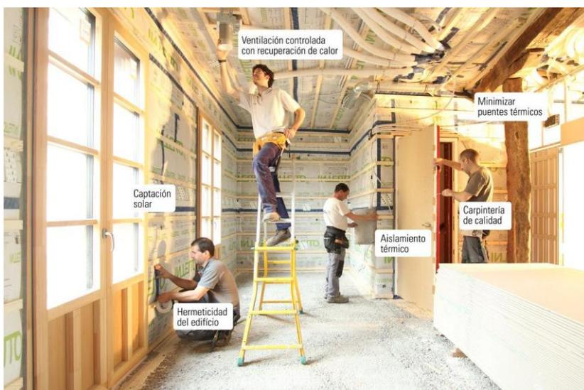
Foto: Componentes de una casa pasiva – Fuente: Bau Passivhaus sl
