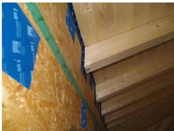
Foto: Proceso constructivo. Hermeticidad – Fuente: Bau Passivhaus sl
